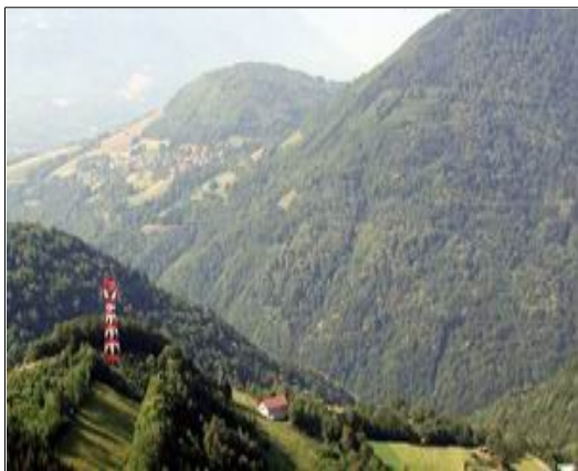
Exemple de lignes dangereuses qui traversent les vallées. Proche d'un aérodrome et peintes elles sont visibles
